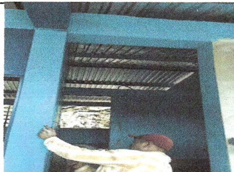
Foto 4: Mantenimiento de puertas del establecimiento.
