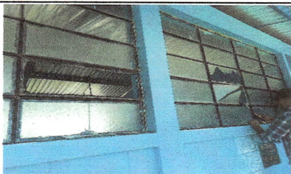
Foto 3: Sustitución de vidrios en mal estado.
