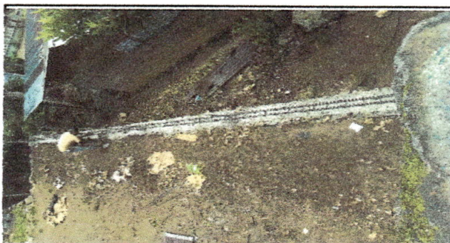
Foto 5: Colocación de circulación con tubo y malla galvanizada.
