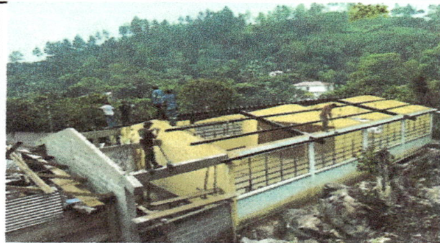
Foto1: Sustitución de Cubierta de lámina.
